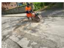
Sciage de la route avant réparation
