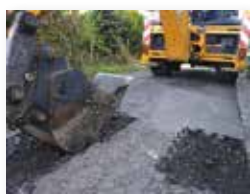
Réparation de la voirie
