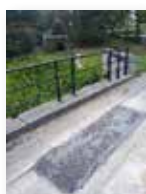
Réparation du pont à Ocquier
