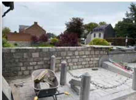
Réparation du mur de soutènement du cimetière d'Ocquier. Démontage des pierres et stèles pour remaçonner la pierre à l'identique. Un bel ouvrage.
